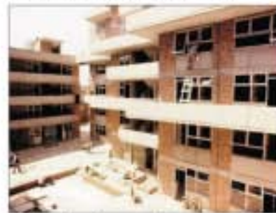
Patio colectivo, conjunto Coahuatlán
