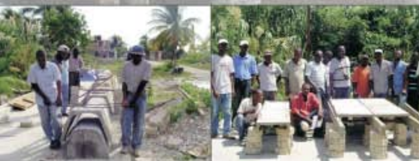
Canal de drenaje / Técnicas constructivas y talleres en Haití. CTDMC-CUBA
