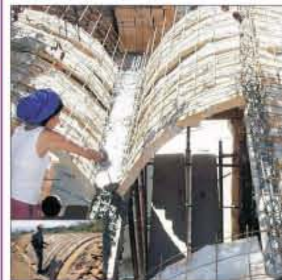
Bóveda ladrillo armado C. G. LOBO, México
