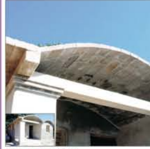
Bóveda de suelo estabilizada CTDMC, Cuba
