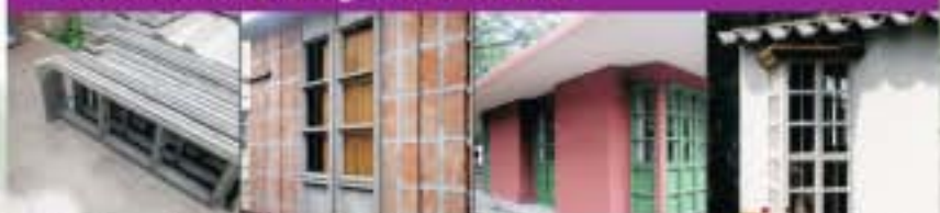
Ventana de hormigón. CEVE. Argentina
