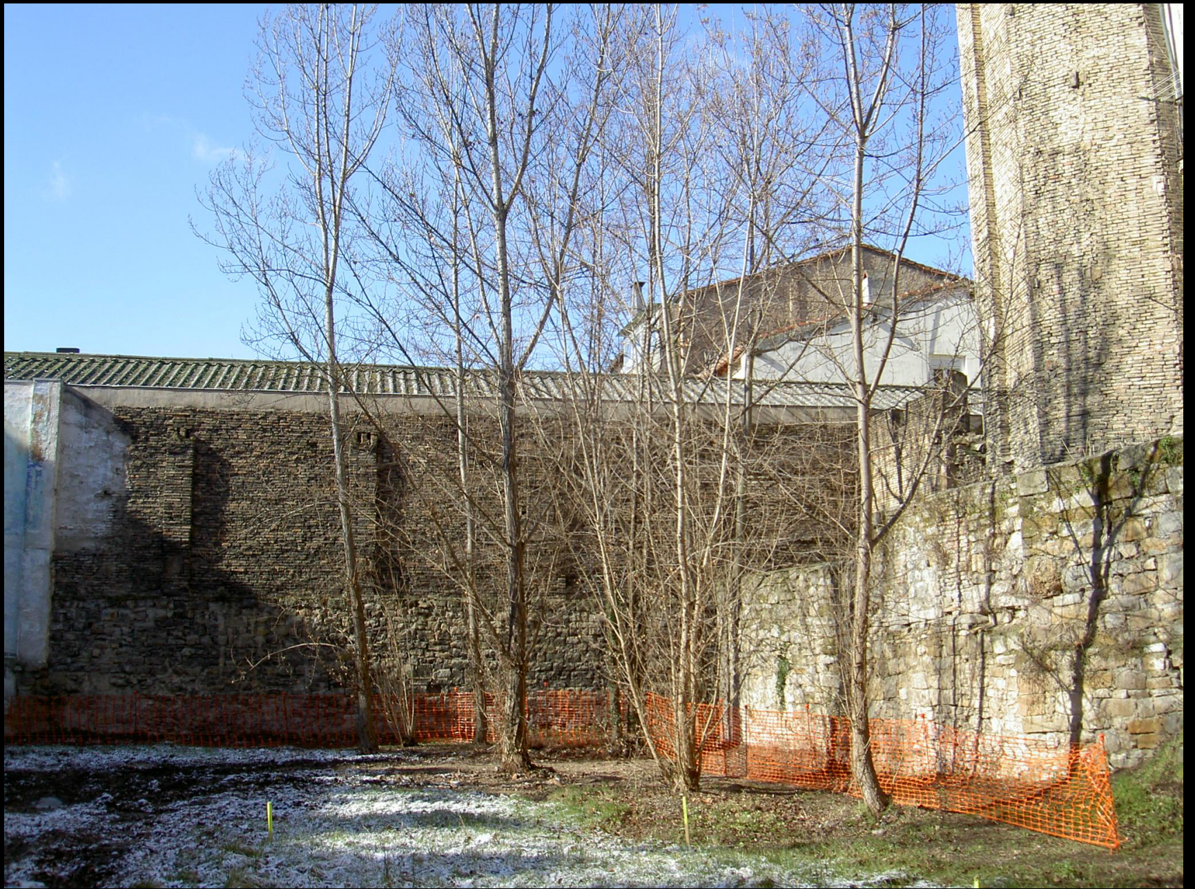
VISTA ESTADO ACTUAL DESDE RINCON DE PELLEJERIA
